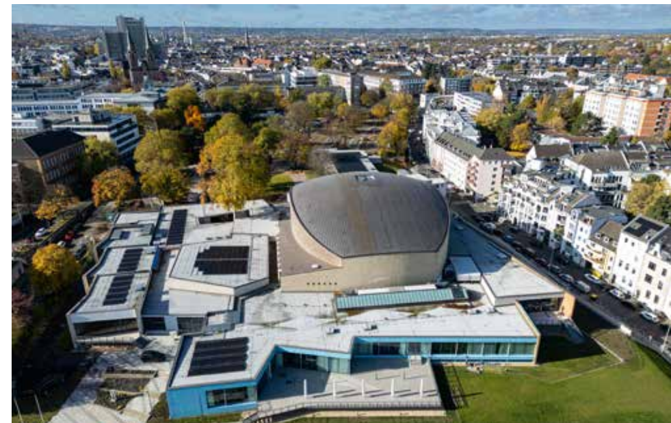
2021 wurden die ersten Kupferbahnen über der Kuppel installiert. Heute hat das Dach noch nicht wieder seine charakteristische grüne Patina.
