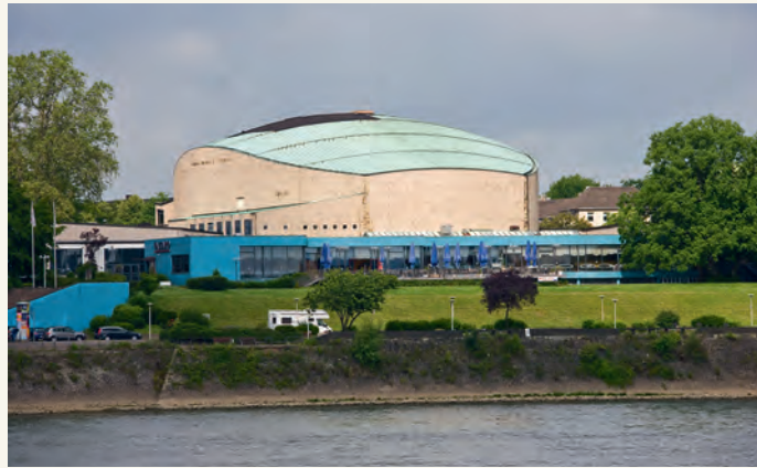
Der 29-jährige Architekt Siegfried Wolske vollendete 1959 den Bau, der zu einem Wahrzeichen der Stadt wurde.
