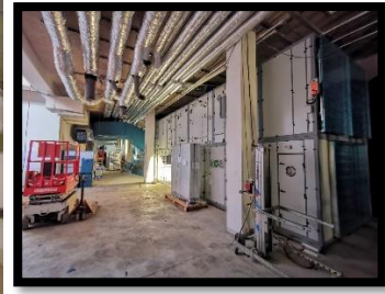
Technikraum auf der Nordseite der Halle, in dem die Haustechnik bereits eingebaut ist. Durch die Öffnung des Daches ist das Notstromaggregat eingelassen, danach wurde die Öffnung verschlossen. Auf dem Bild, das wir im Rundbrief 1.2020 veröffentlicht haben (r.) war der Raum noch weitgehend leer. © Städtisches Gebäudemanagement Bonn
