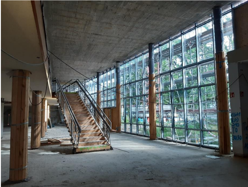
Blick auf die neuen Fenster im Großen Foyer der Beethovenhalle © Städtisches Gebäudemanagement Bonn
