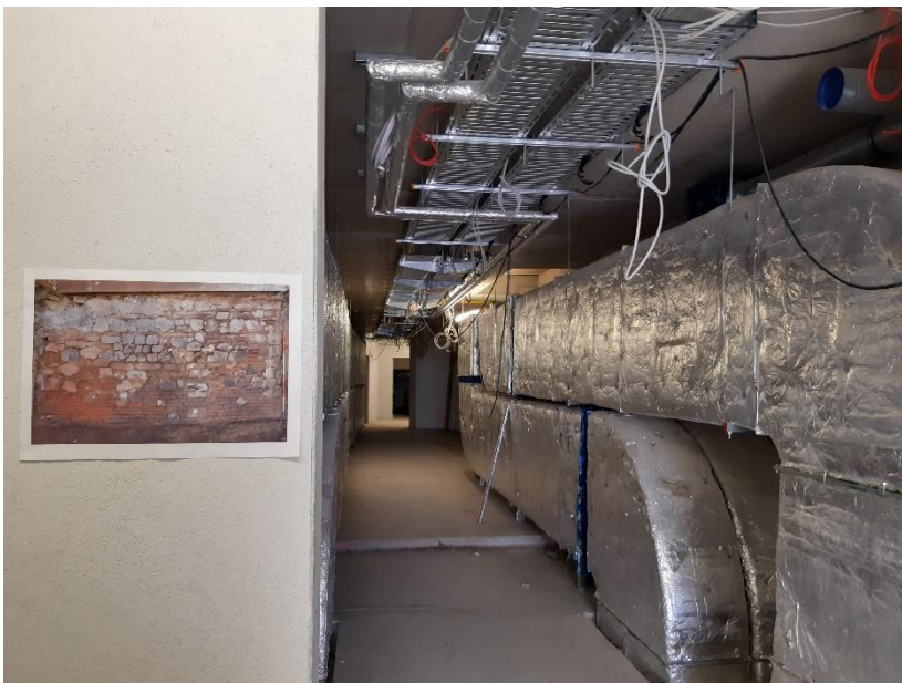
Links neben dem Durchgang zur Technik ist ein Foto zu sehen, das die nördliche Begrenzung der Bonner Stadtmauer wiedergibt, so wie sie beim Durchbruch zum Verbindungsgang zur Be- und Entladungsrampe vorgefunden wurde. Die Barockmauer ist bodendenkmalpflegerisch untersucht und dokumentiert worden. © Städtisches Gebäudemanagement Bonn
