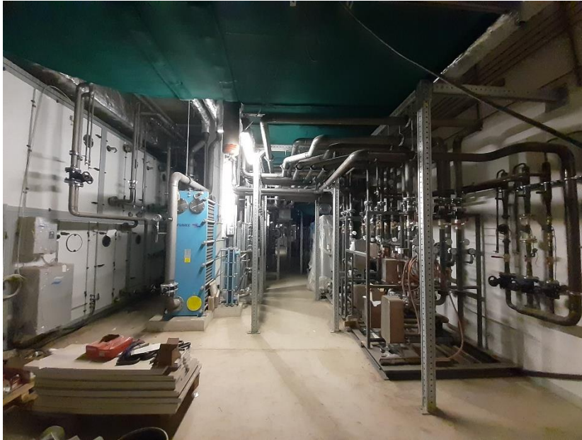
Technikraum auf der Nordseite der Halle, in dem die Haustechnik bereits eingebaut ist. Durch die Öffnung des Daches ist das Notstromaggregat eingelassen, danach wurde die Öffnung verschlossen. Auf dem Bild, das wir im Rundbrief 1.2020 veröffentlicht haben (r.) war der Raum noch weitgehend leer. © Städtisches Gebäudemanagement Bonn
